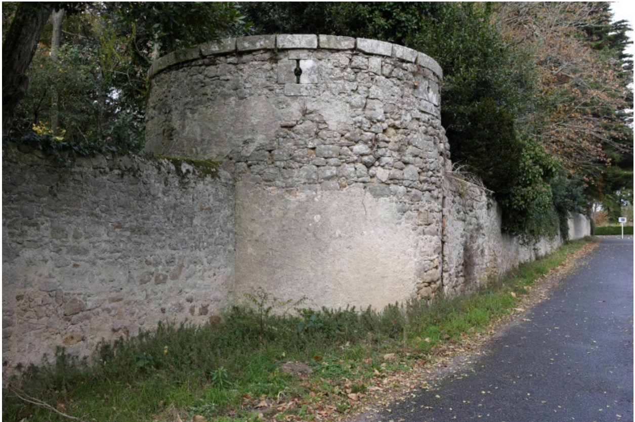
Mur de clôture. Tour est.
