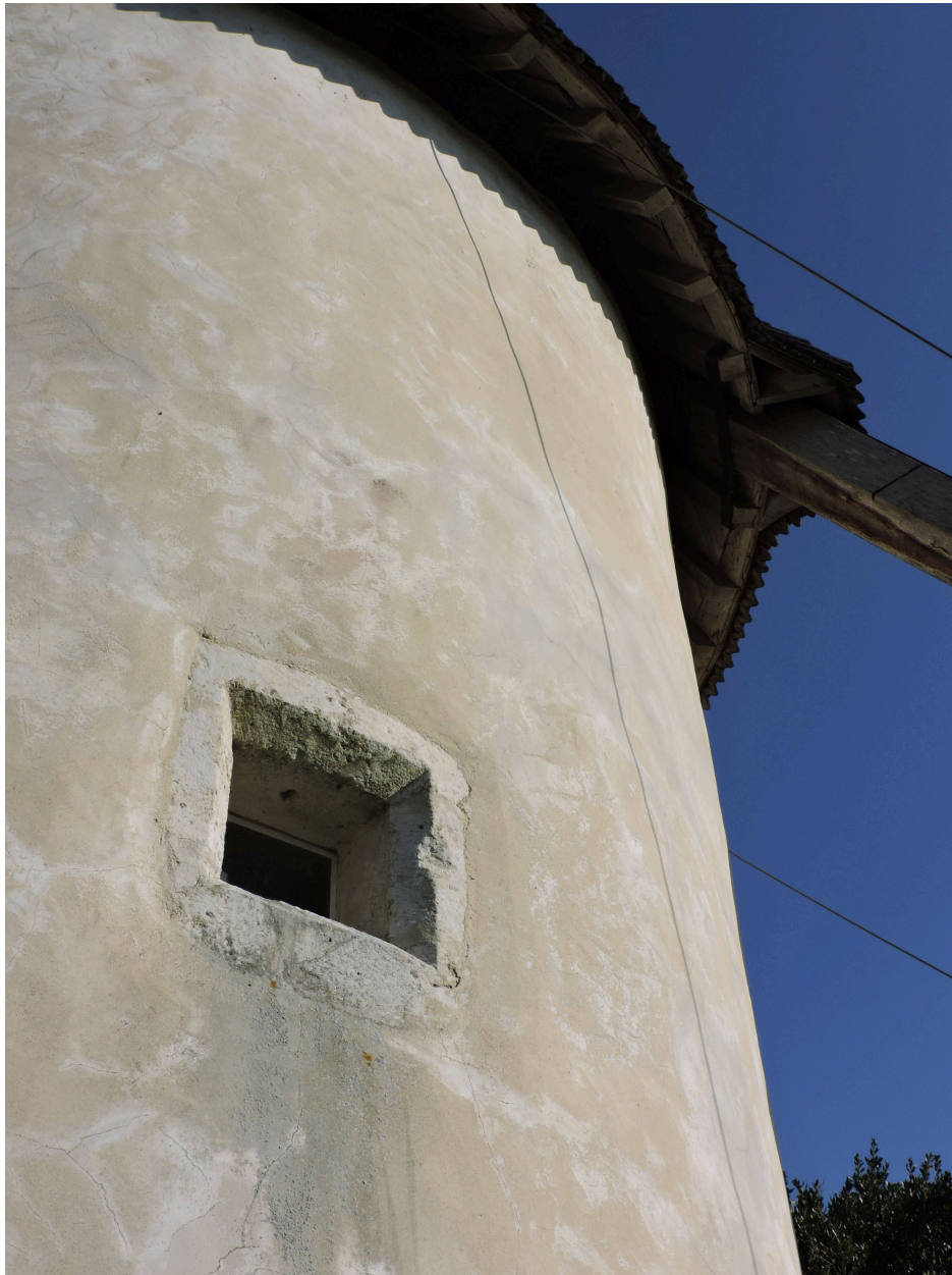
Petite baie à encadrement chanfreiné au sud-ouest du moulin.
