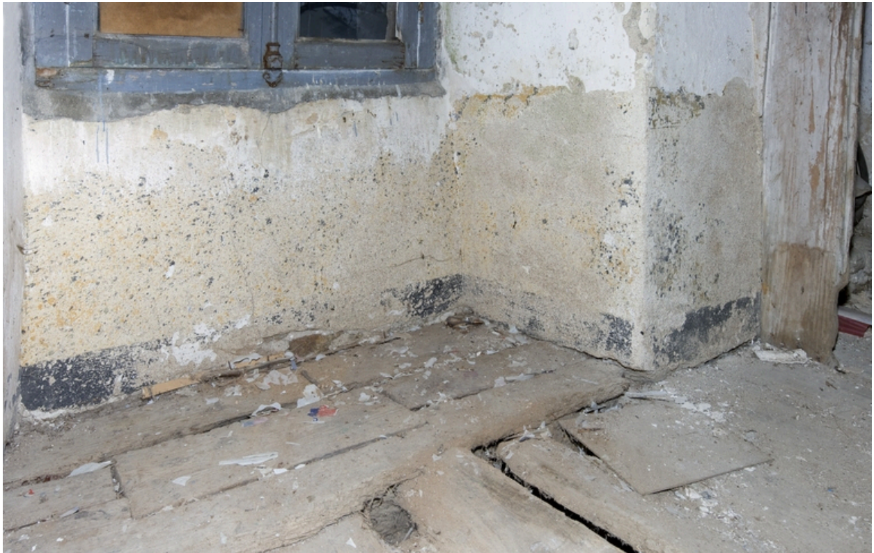
Détail de la plinthe peinte sous la fenêtre.
