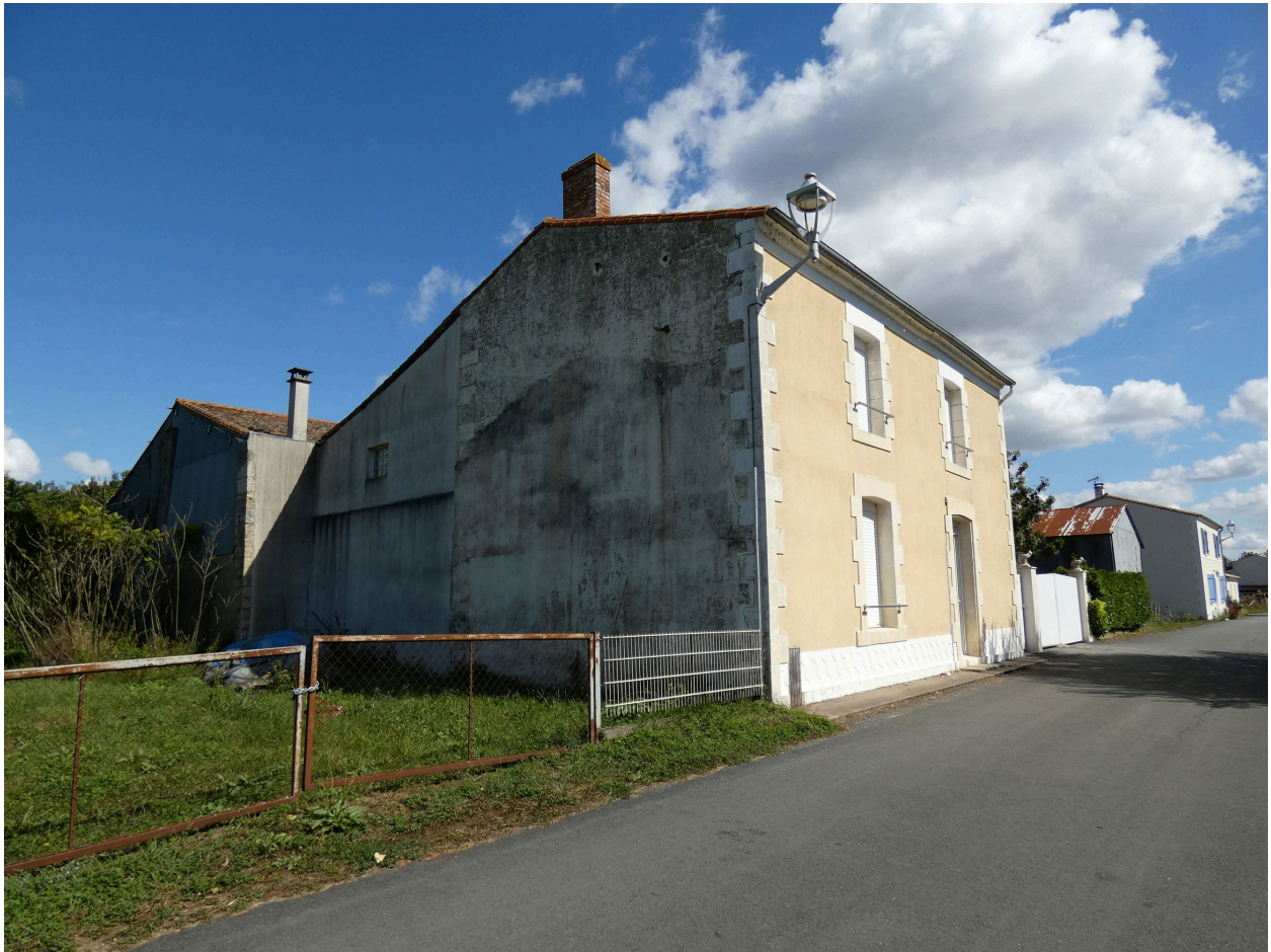
L'ancienne ferme vue depuis l'ouest.
