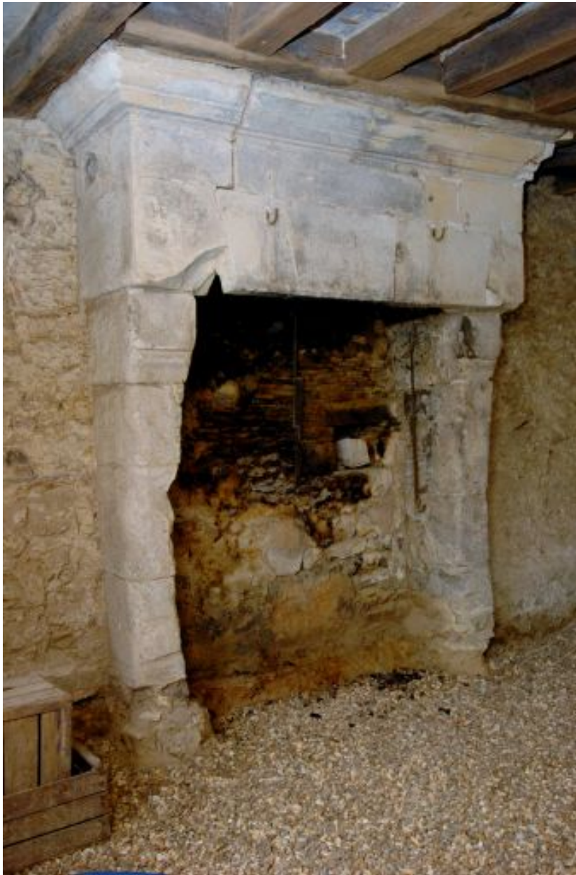
Rez-de-chaussée, salle de gauche : cheminée.
