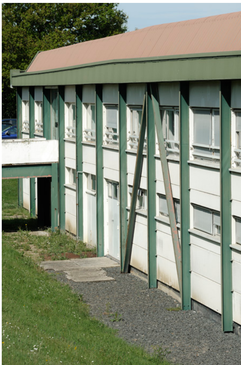
Usine SACAIR : façade sud.
