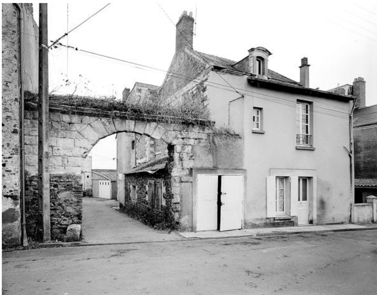
Portail et façade antérieure, après restauration, 1985.
