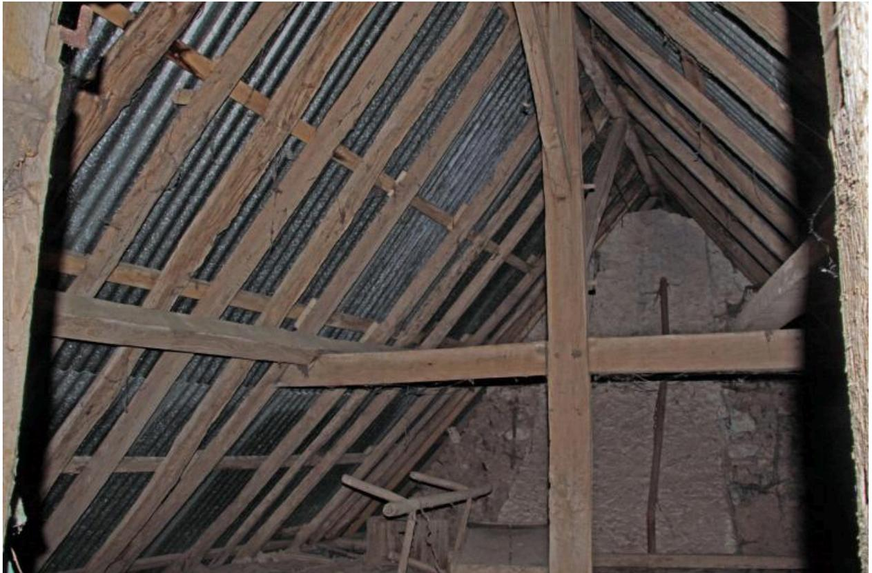
Maison, comble : charpente entre cloison à pan de bois et pignon maçonné (vers étable).
