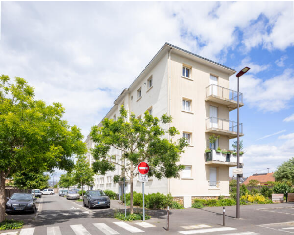
Vue du bâtiment D rue Régine-Deforges.
