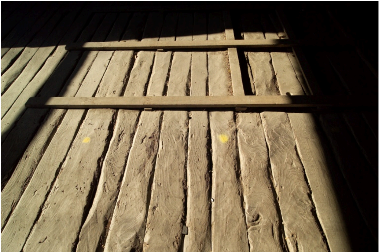
Cour d'entrée, parquet de l'étage de stockage d'un hangar.
