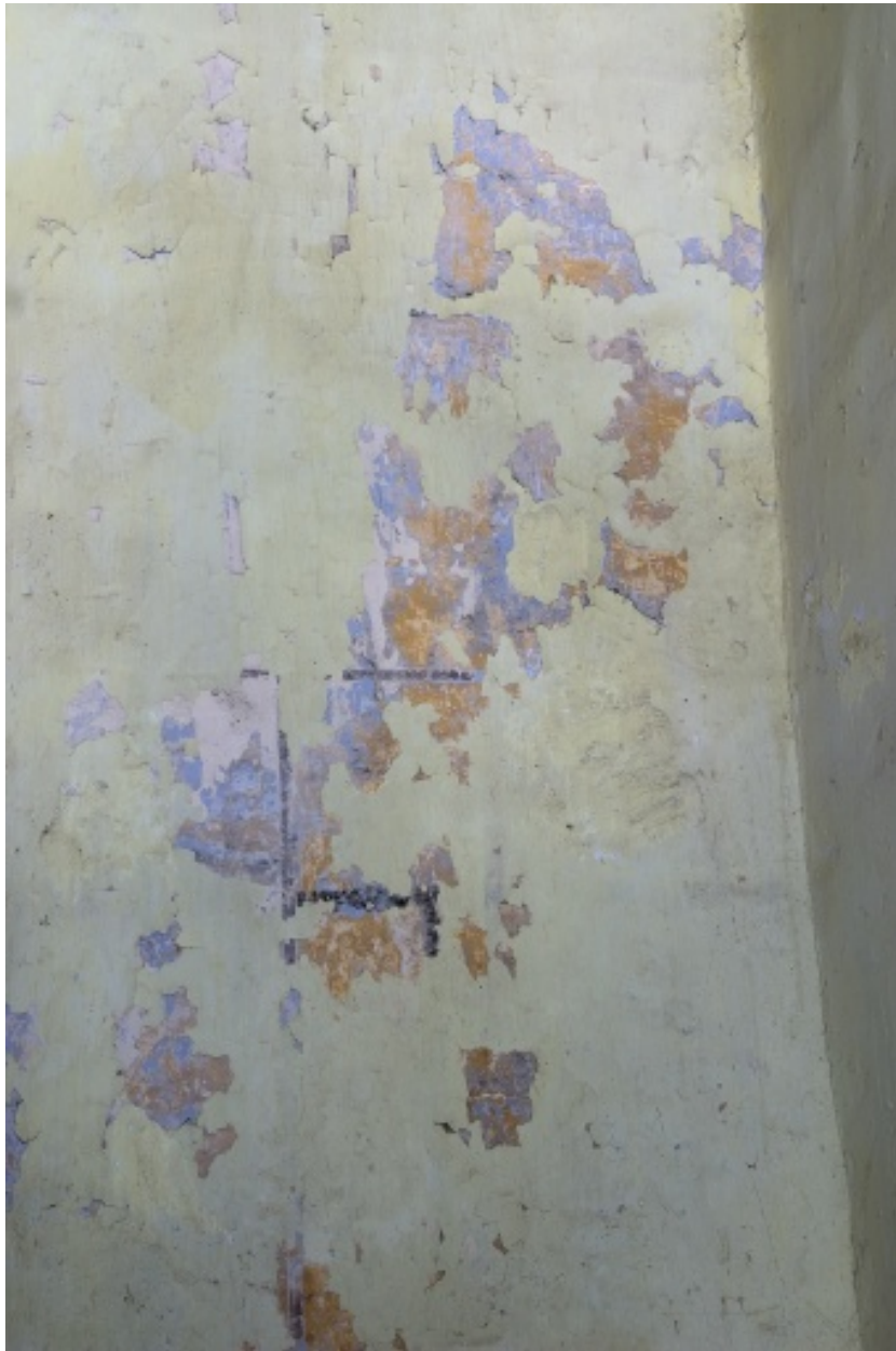
Détail du mur du vestibule : décor de faux appareil.
