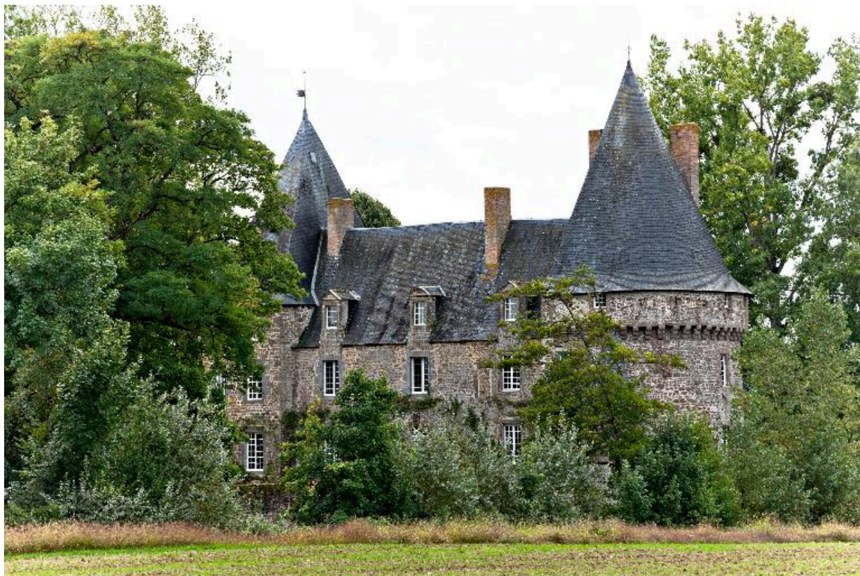
L'élévation antérieure vue depuis la rive droite de la Mayenne, au nord-est.
