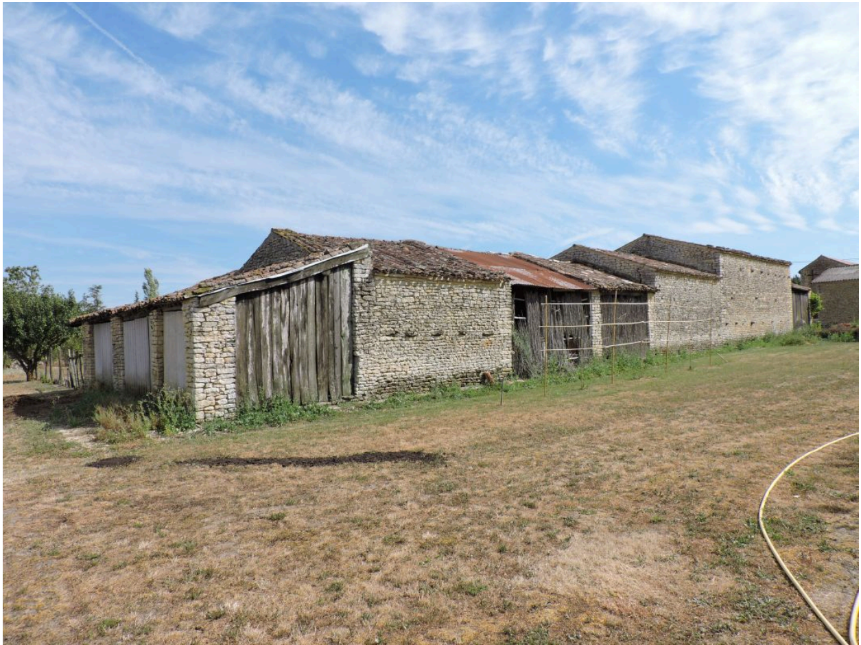
L'alignement de dépendances vu depuis le nord.
