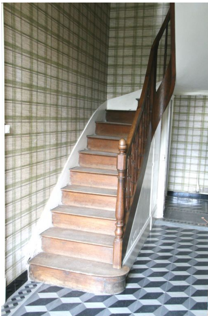
La nouvelle maison, vestibule : escalier dans oeuvre en bois.
