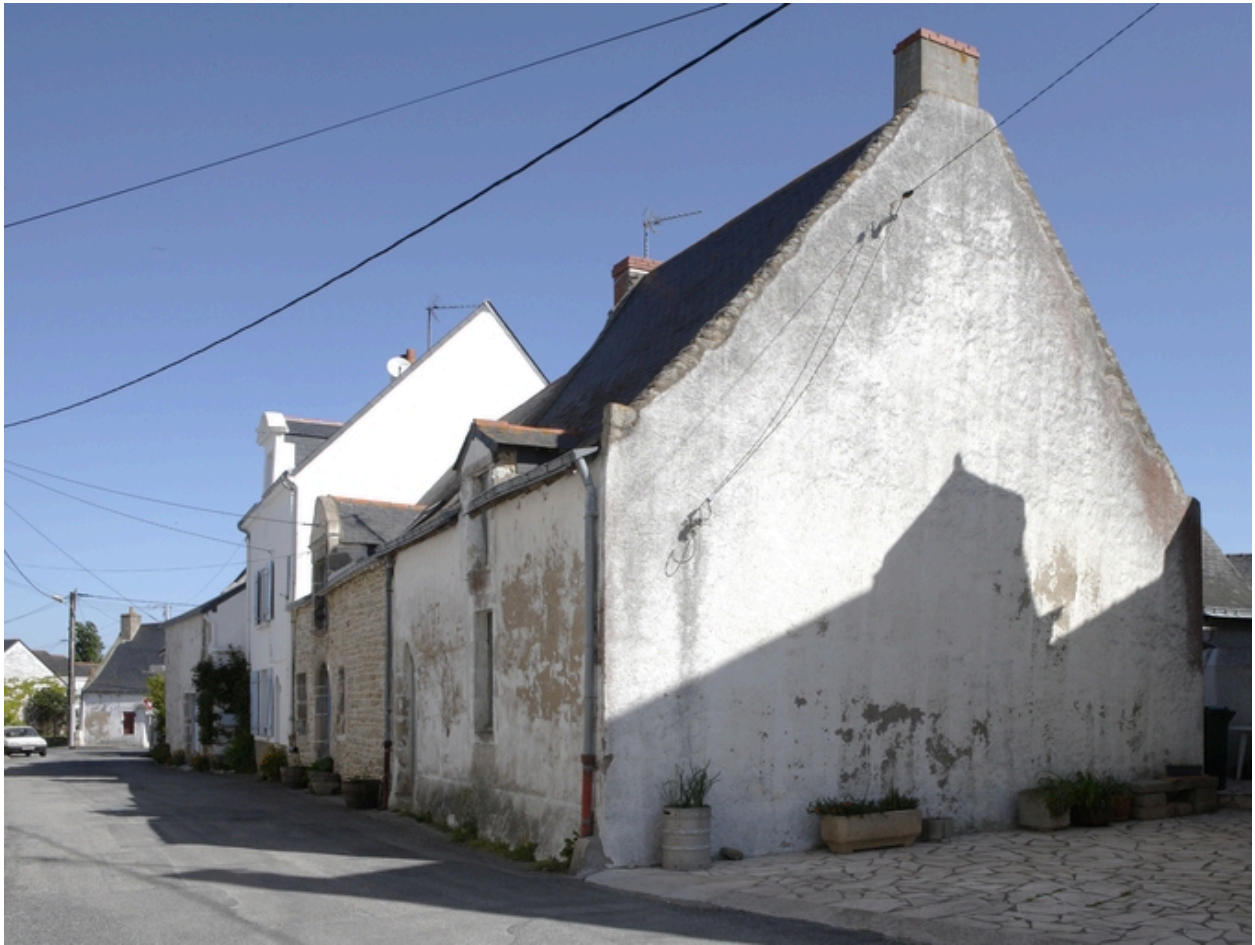
Vue d'ensemble de la rangée depuis le sud-est.
