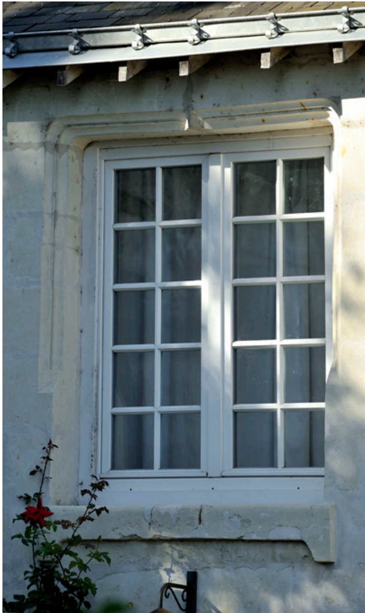
Façade est, étage : ancienne croisée avec mouluration de cavets à ressaut et congés.
