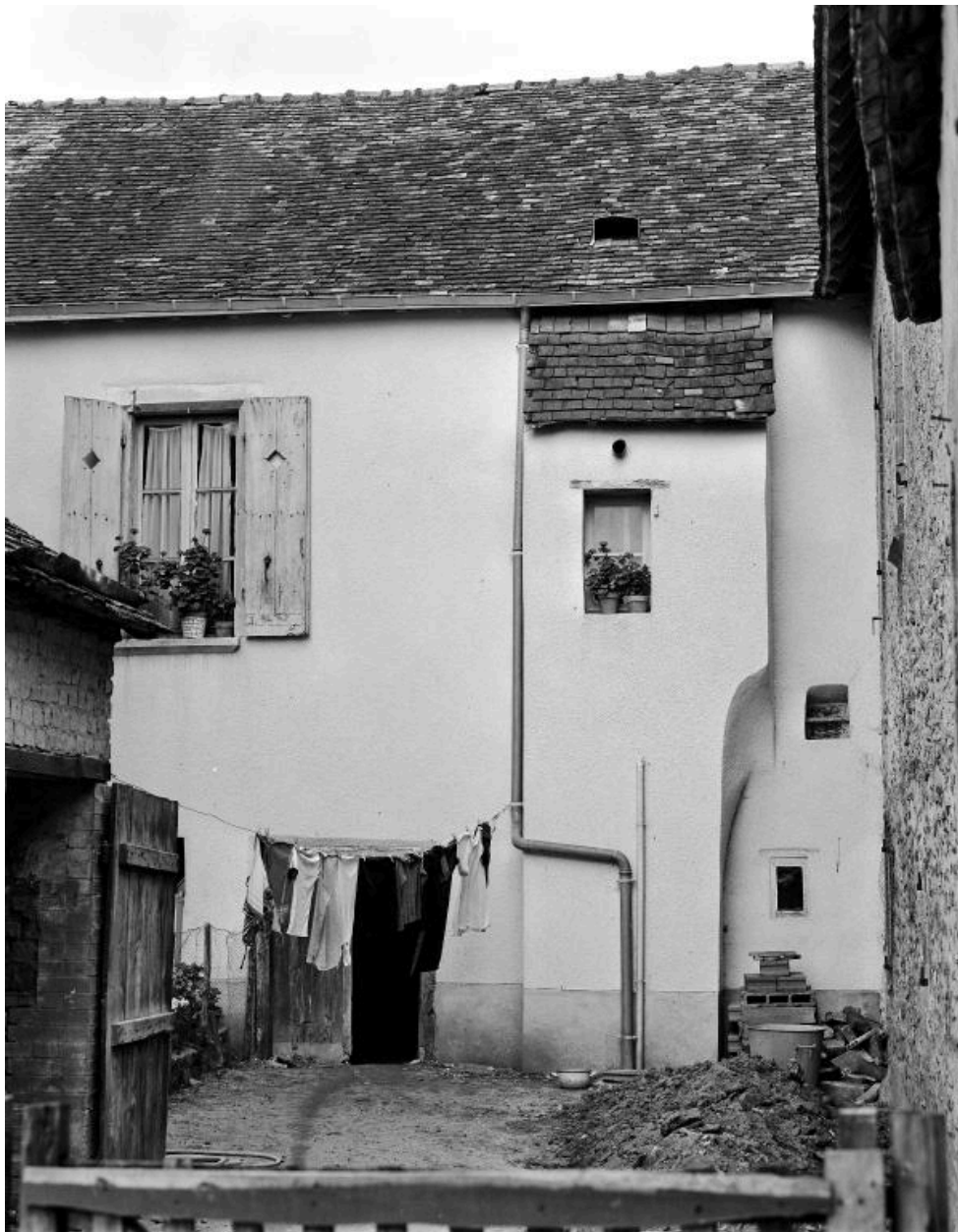
Une façade arrière à fenêtre chanfreinée et partie saillante, rue de l'Etang, 1978.
