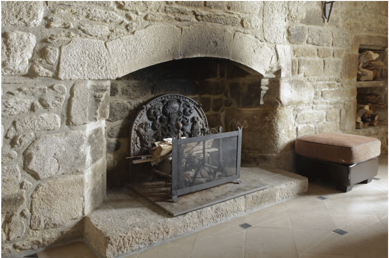
Logis. Aile est. Cuisine. Cheminée.
