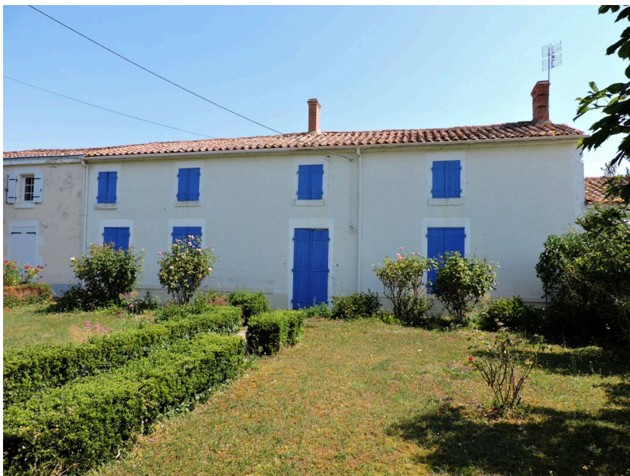
Le logis vu depuis le sud-ouest.
