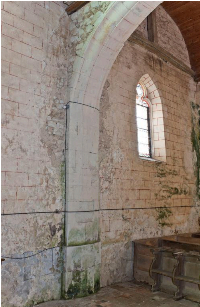
Détail de l'arcade entre les chapelles sud-est et sud-ouest.
