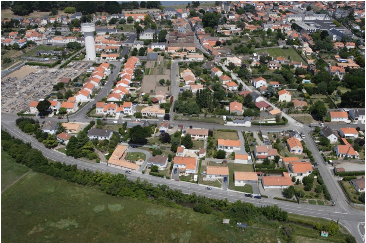
Vue aérienne du lotissement (à droite du cimetière), 2010.
