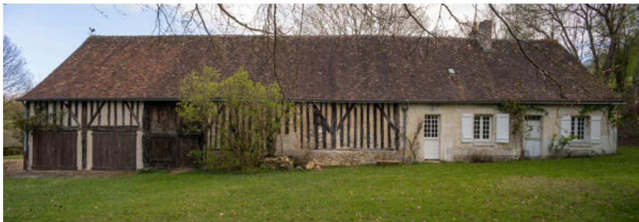
Grange-étable-remise et logement : façade ouest.
