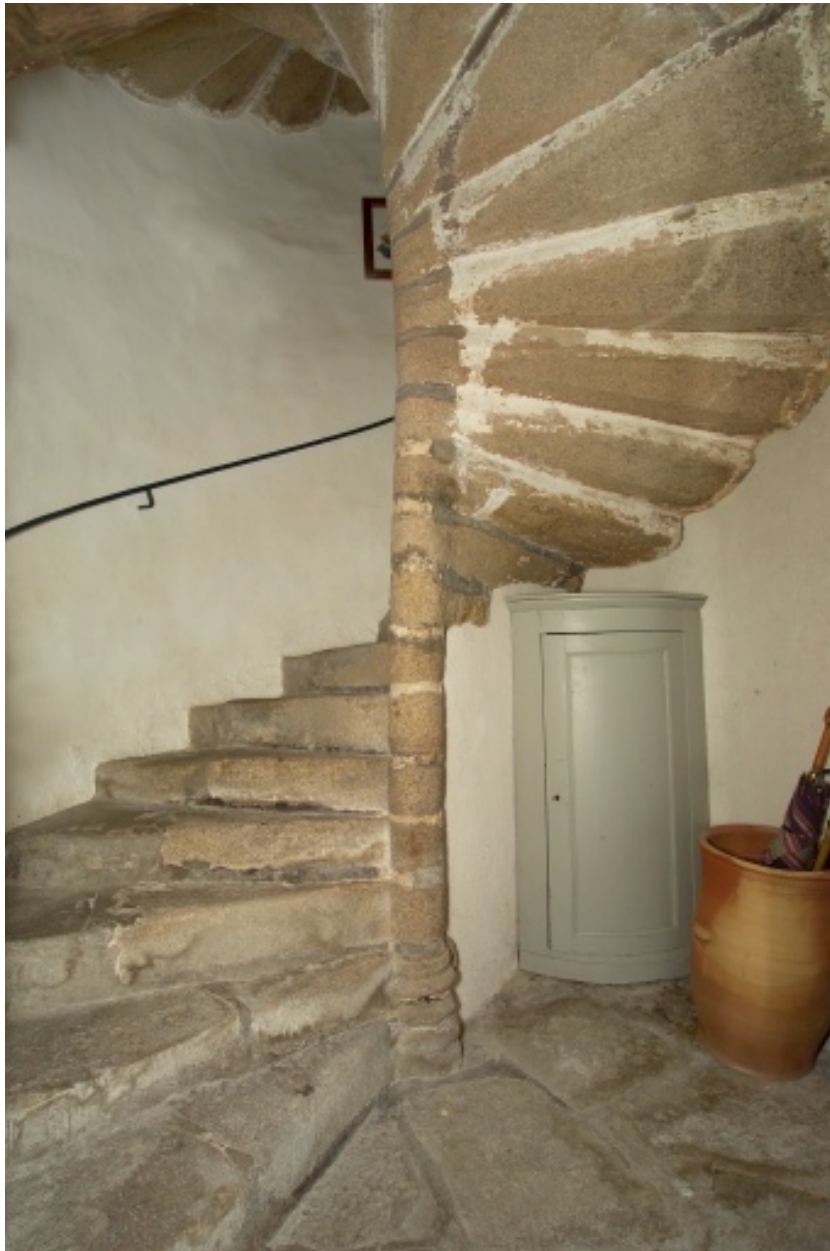
Vue de l'escalier depuis le rez-de-chaussée.
