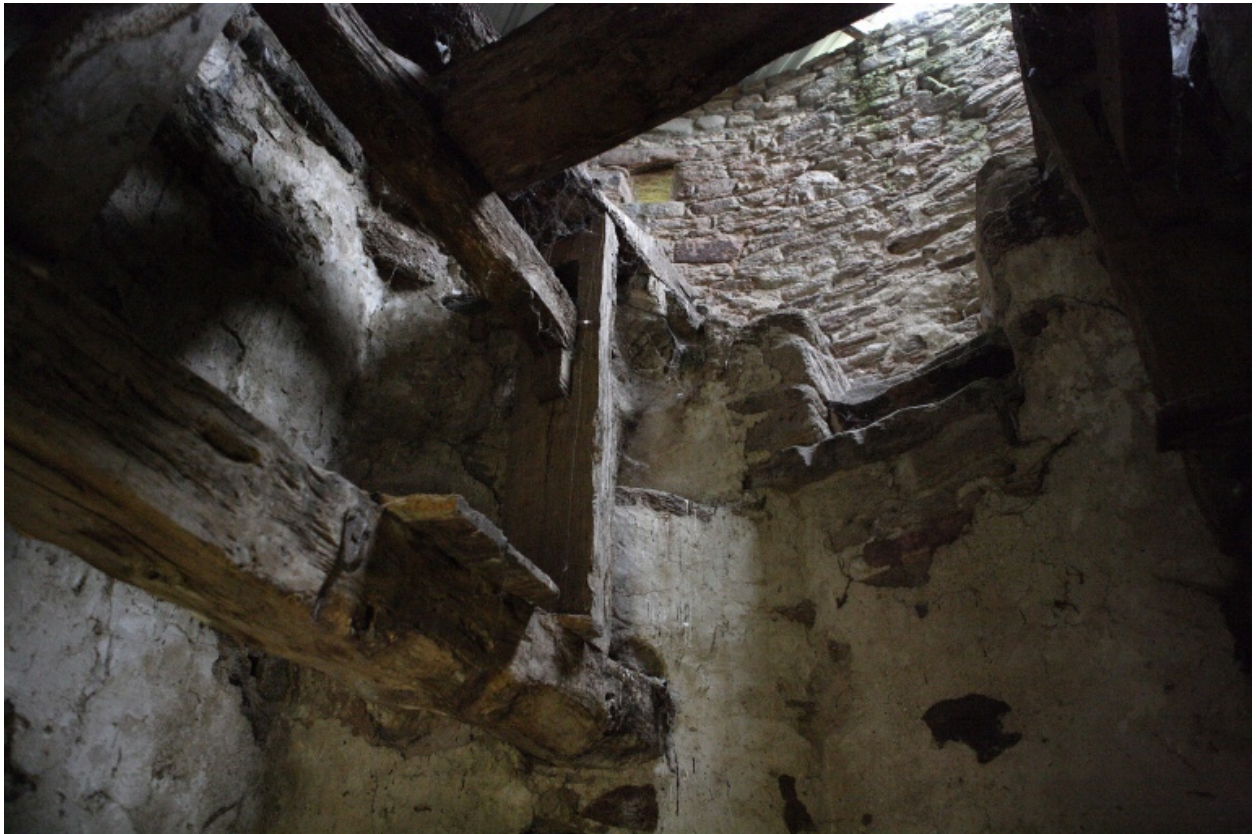
Intérieur de la tourelle, partie nord : détail de l'escalier haut menant à la cage et partie du cadre ouest de la trempure.
