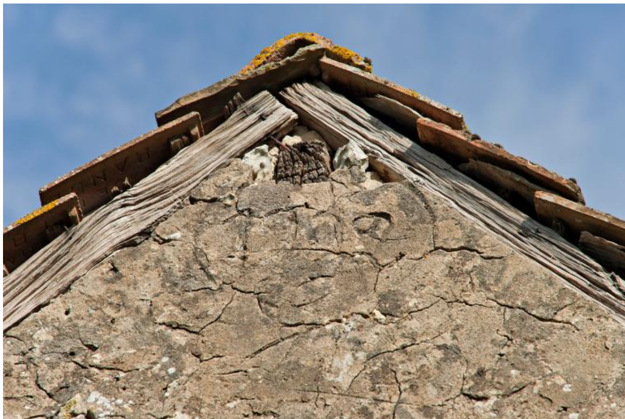
Hangar : pignon maçonné avec date portée (1902).
