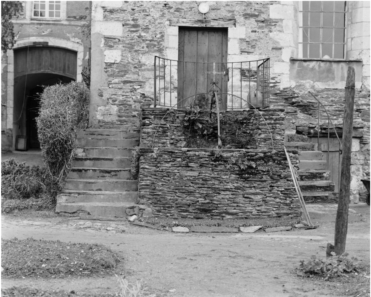
Aile du réfectoire, façade est, extrémité sud : puits adossé à l'escalier extérieur.
