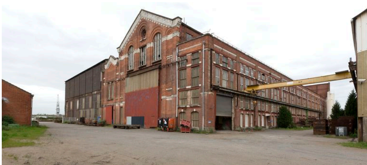
Vue d'ensemble de la centrale électrique.
