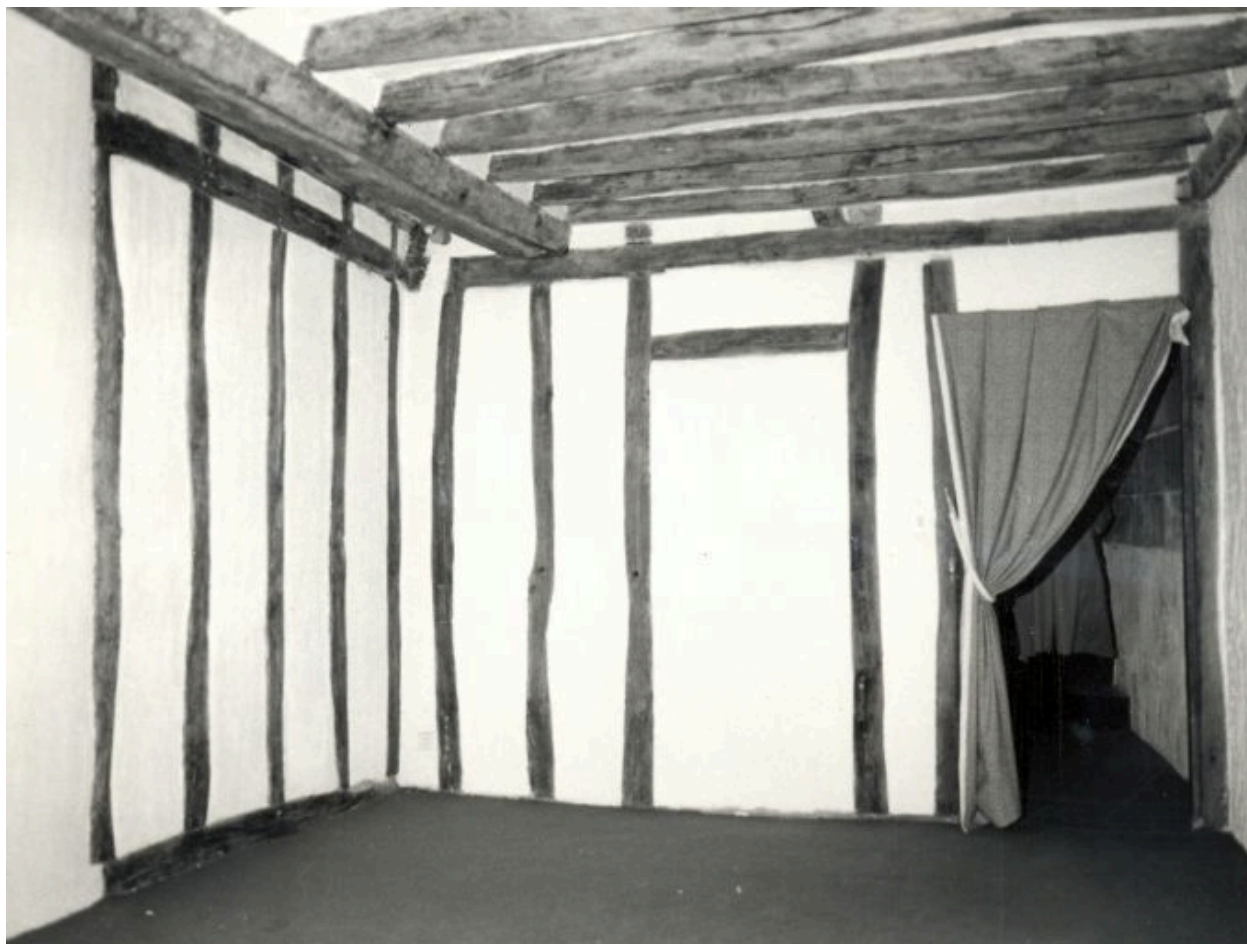
3e étage, pièce antérieure, mur postérieur et angle gauche.
