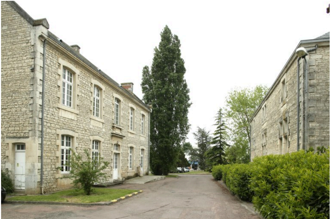
Bâtiments isolés au sud de la cour (cuisines et orphelinat sur le plan de 1909). Vue prise de l'ouest.
