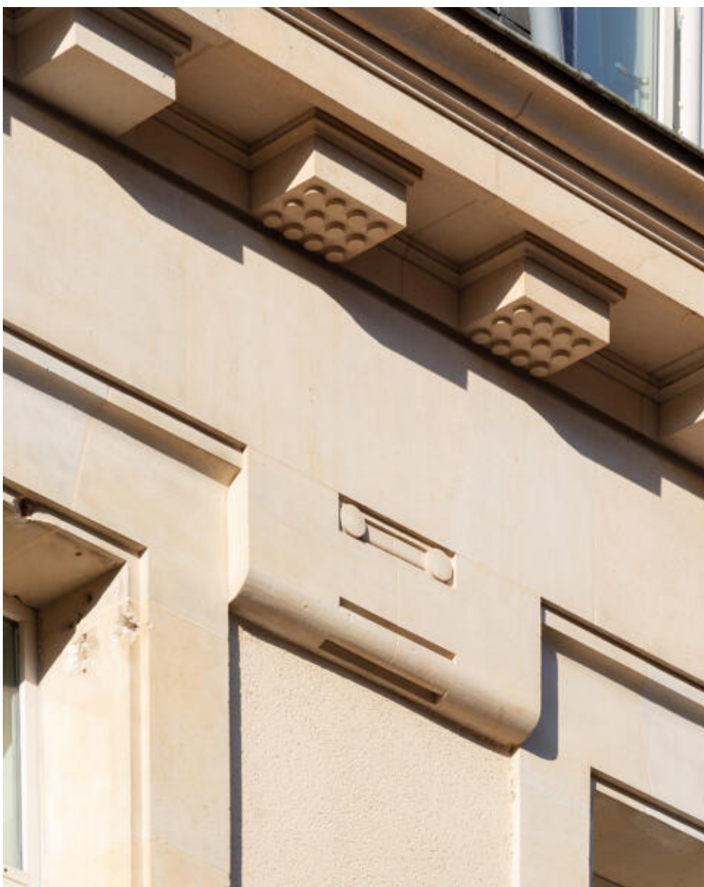
Détail des modillons sous corniche du bâtiment rue Saint-Bertrand.
