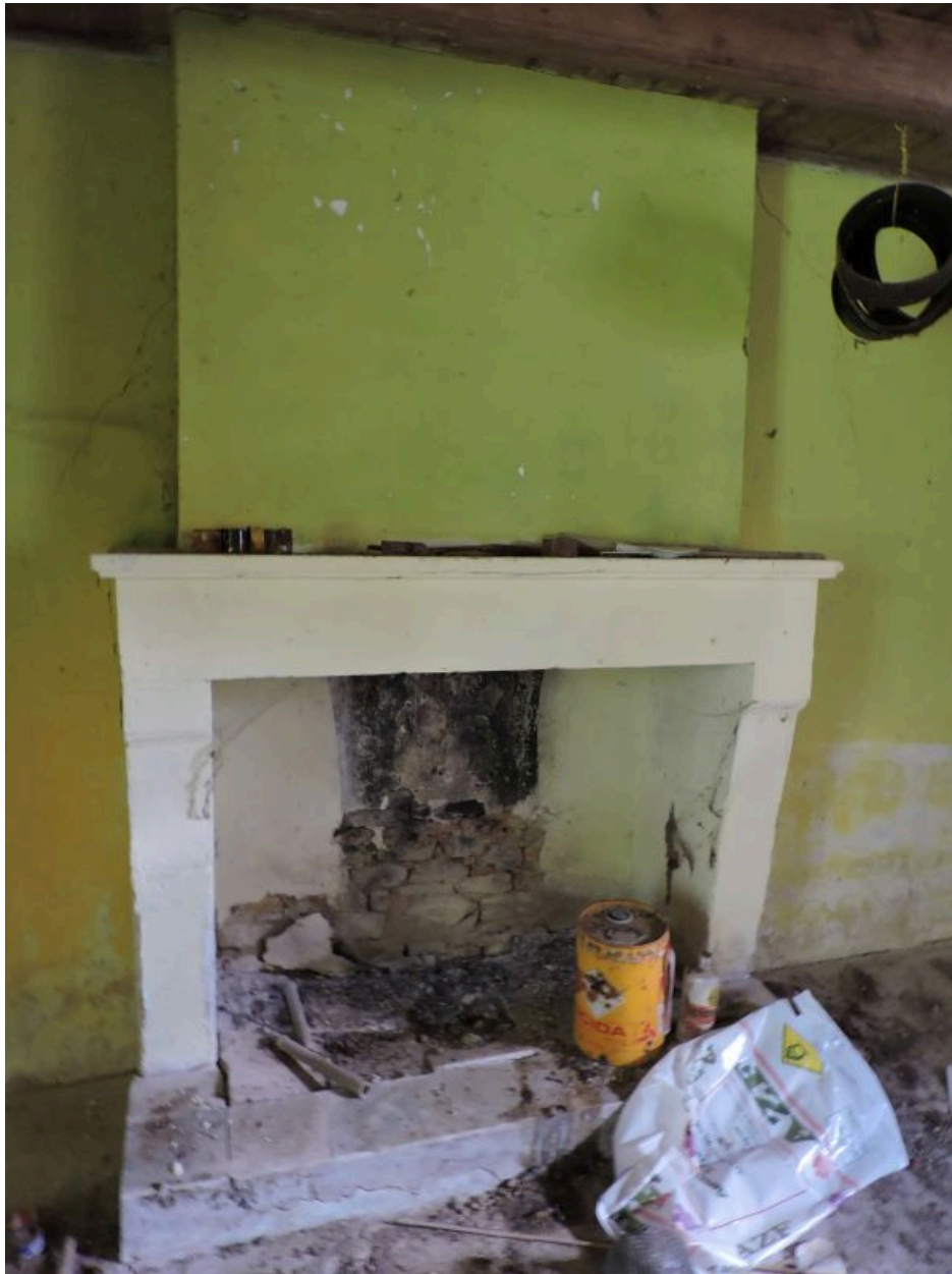
La cheminée au rez-de-chaussée de la partie haute du logis.
