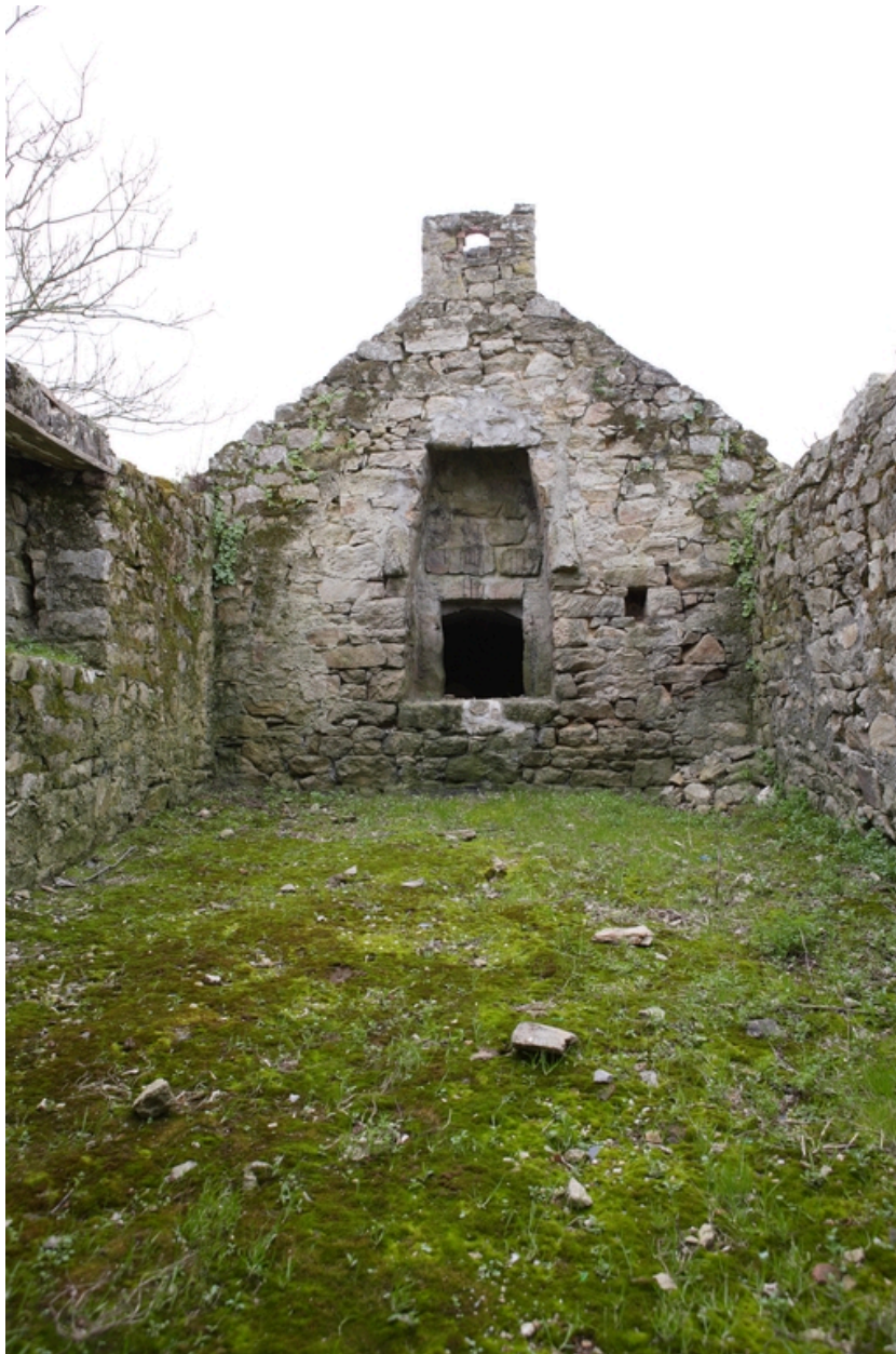
Vue de l'intérieur du fournil commun.
