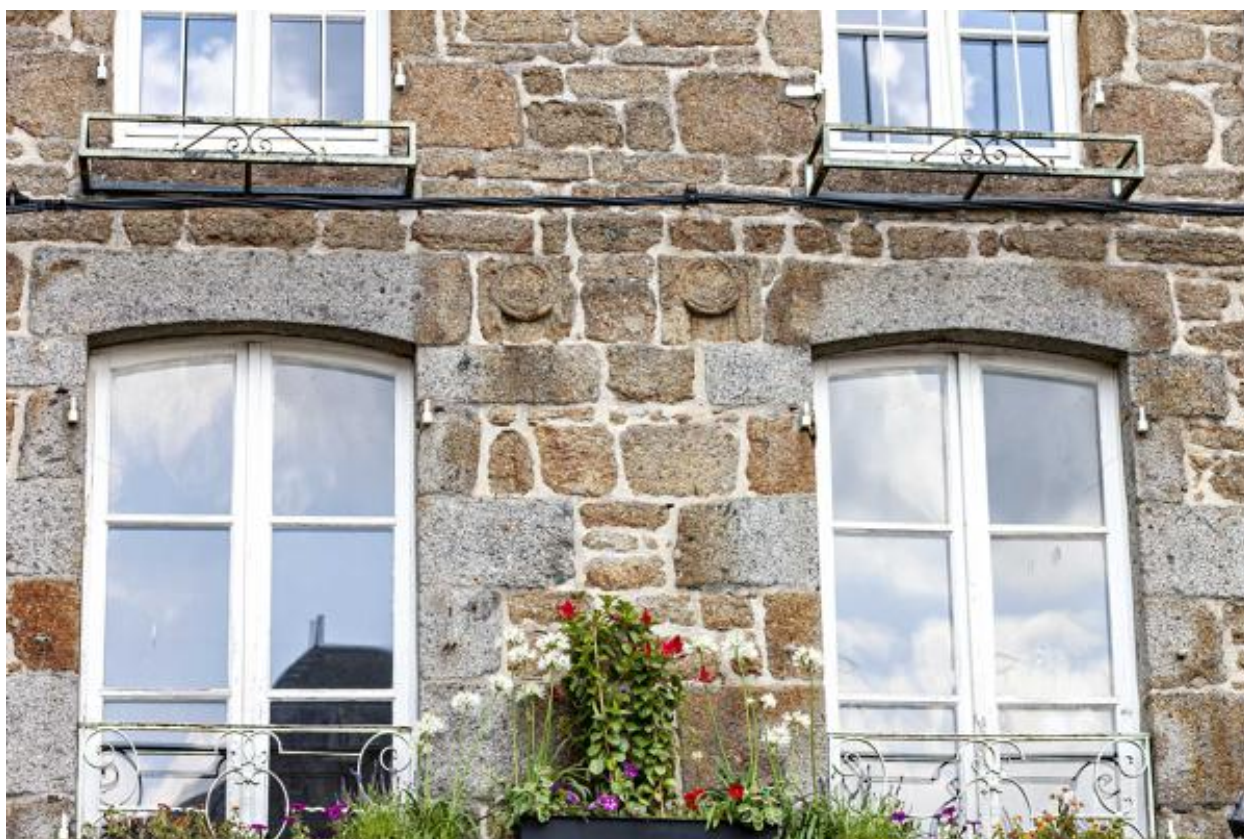
Façade du 15 Grande-Rue, médaillons.
