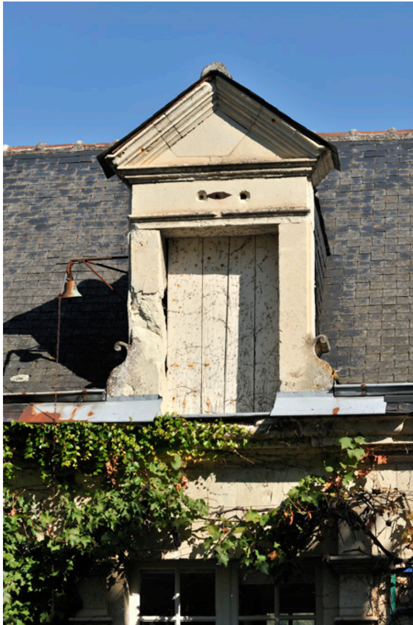
Corps ouest, lucarne axiale du bâtiment principal.
