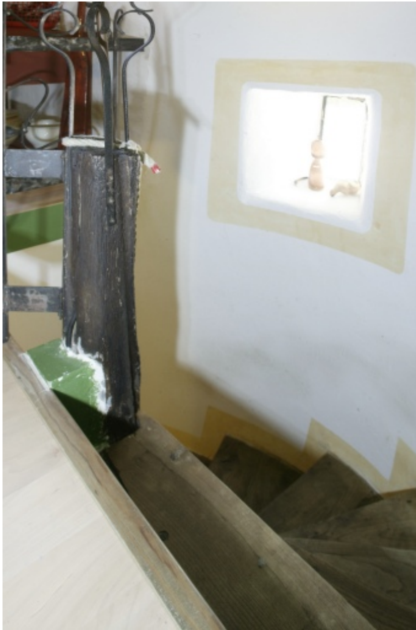
Partie haute de l'escalier vu depuis le comble avec noyau et jour rectangulaire.
