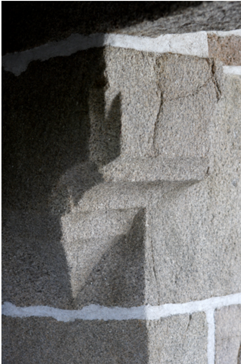
Logis. Aile sud. Cheminée de la salle. Détail du congé du piédroit de droite.
