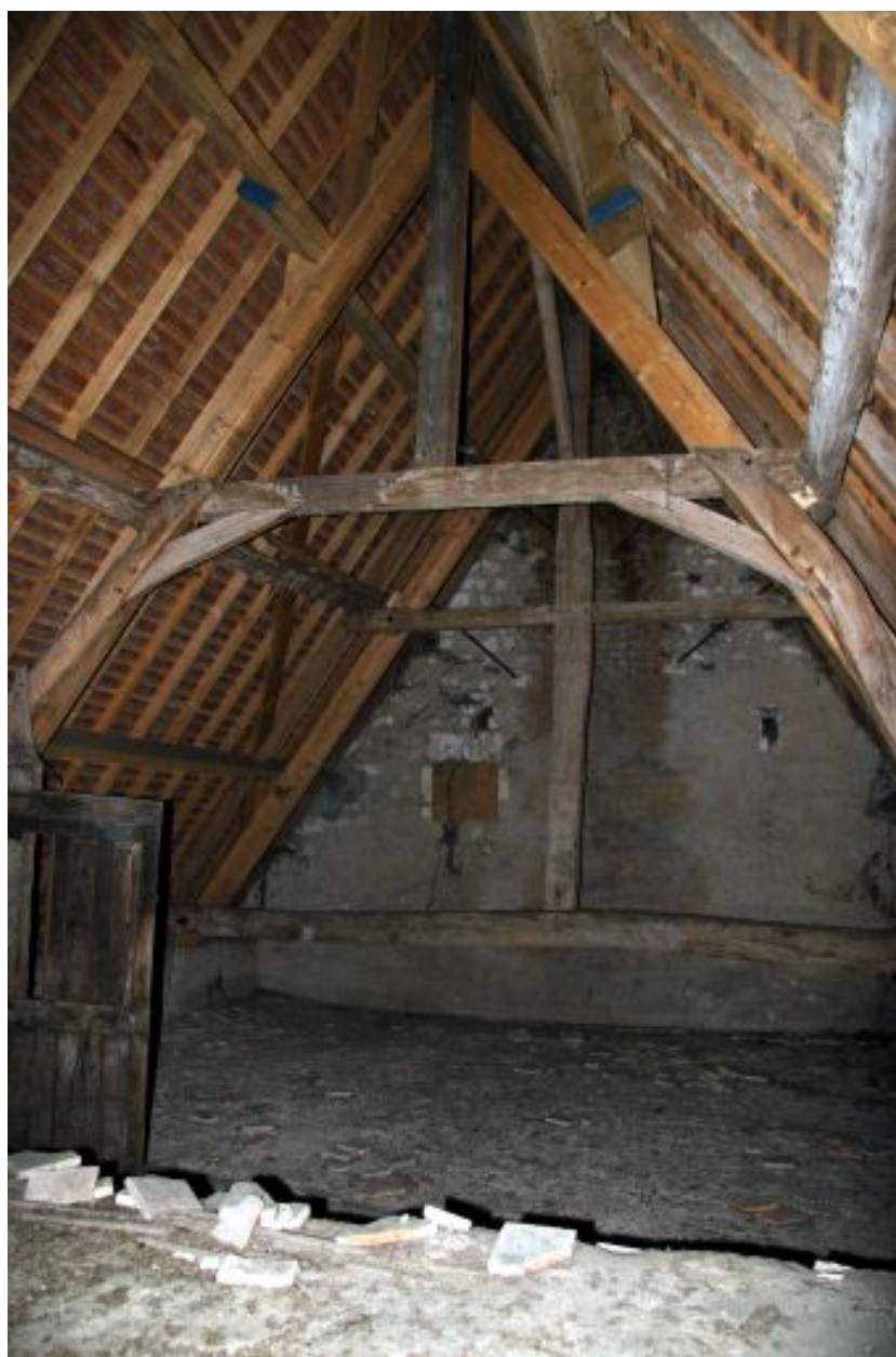
Charpente du surcroît très remaniée.
