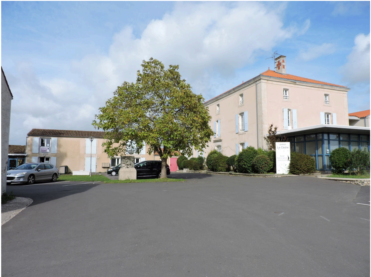
La propriété vue depuis le sud.
