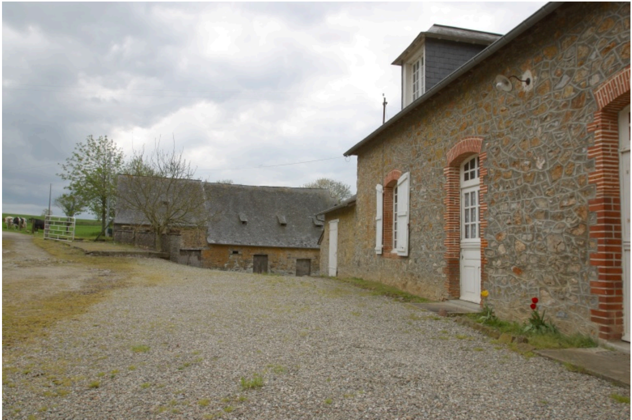
L'ancien logis et la façade principale du logis vus depuis la cour au nord-est.
