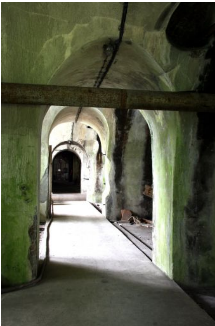
Rez-de-chaussée : couloir longitudinal voûté.
