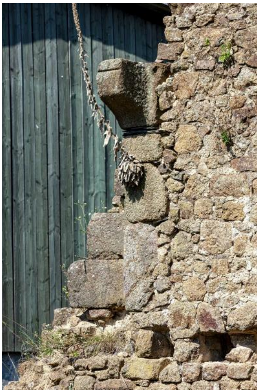
Corps de logis nord, vestiges de cheminée.
