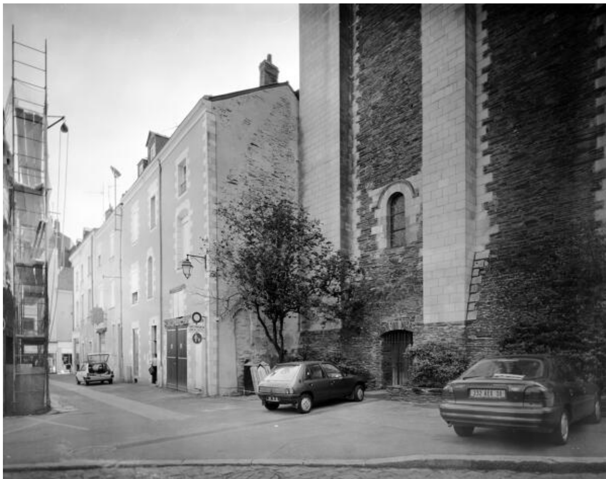
Premier logis abbatial (vestiges) : pignon sud et élévation ouest, sur la rue du Musée.
