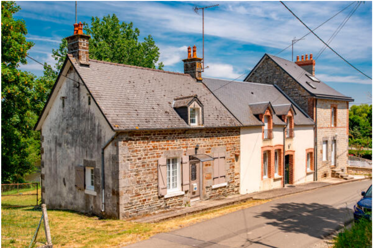
Ecart du Pont de Couterne, maisons (ZE 136-141).
