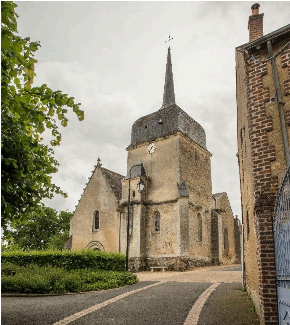
Vue générale prise depuis le sud-ouest.
