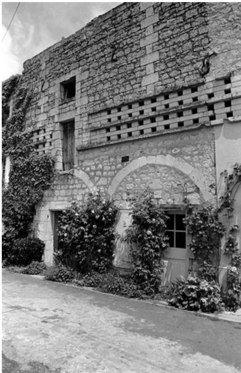
Vue de travées de l'aile est de l'ancien hôpital, en 1979.
