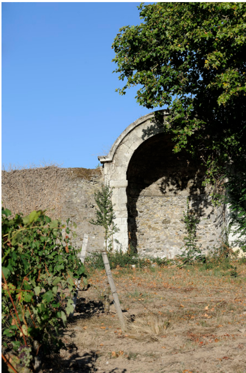
Cabane viticole en pierre s'appauyant sur un mur de clôture.
