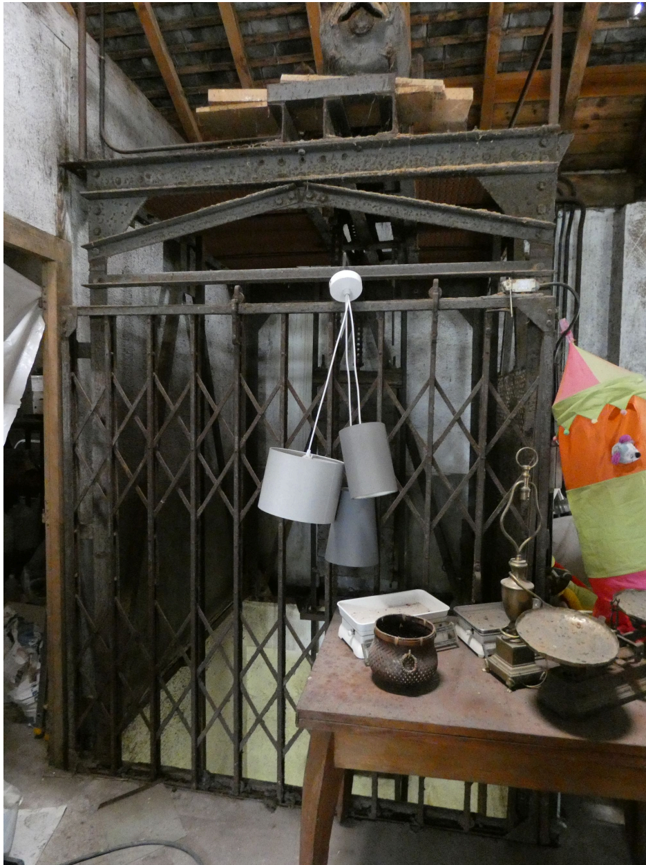
Le monte-charge dans le corps principal de bâtiment sud, à l'étage.
