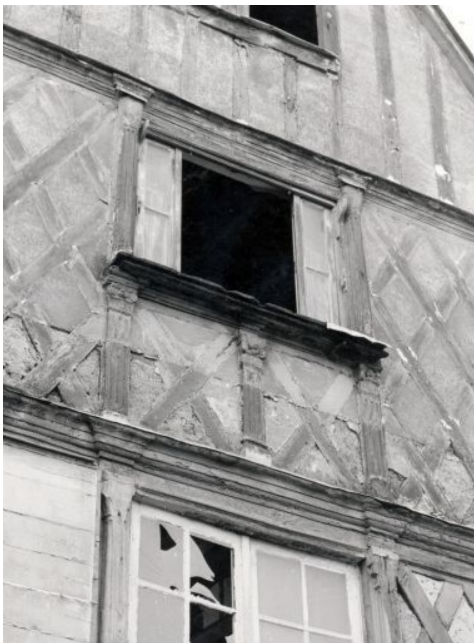
Elévation antérieure, 2e étage : fenêtre.
