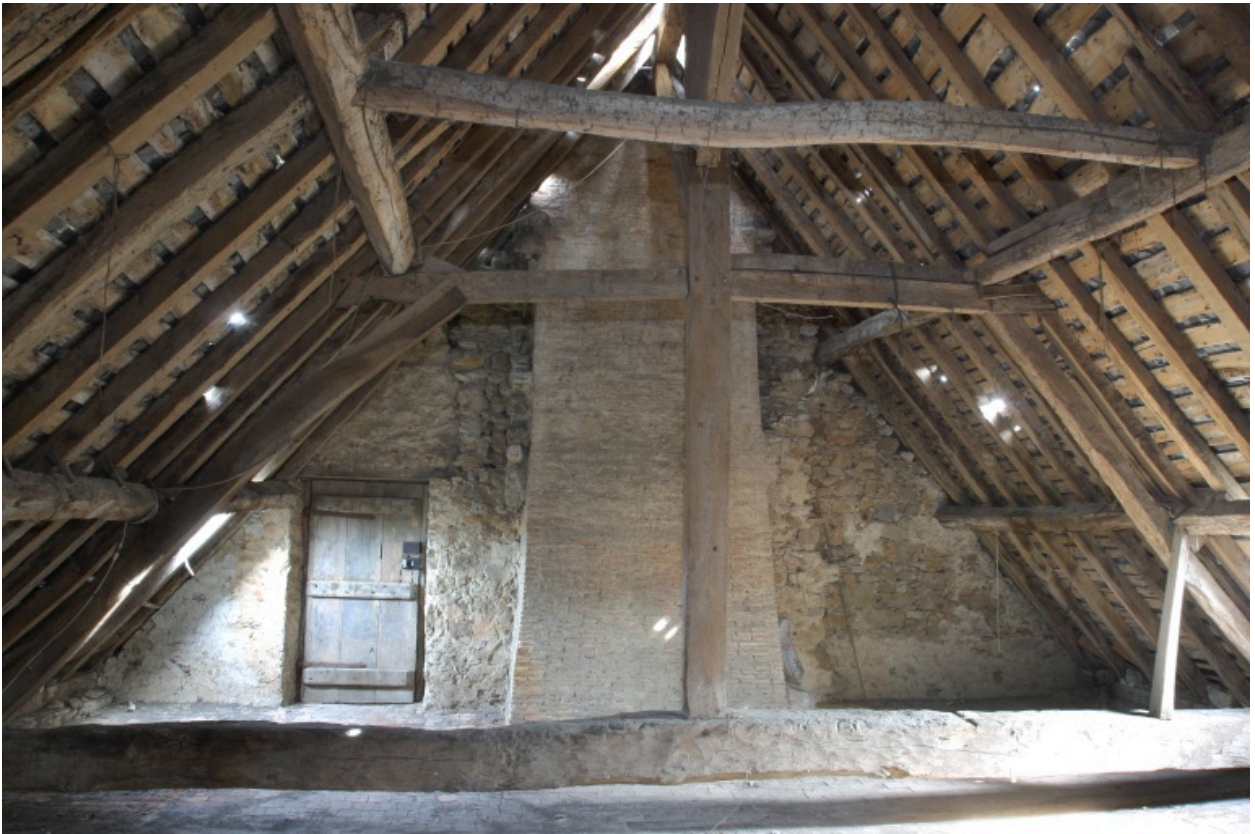
Comble du corps sud : la charpente vue depuis le sud.
