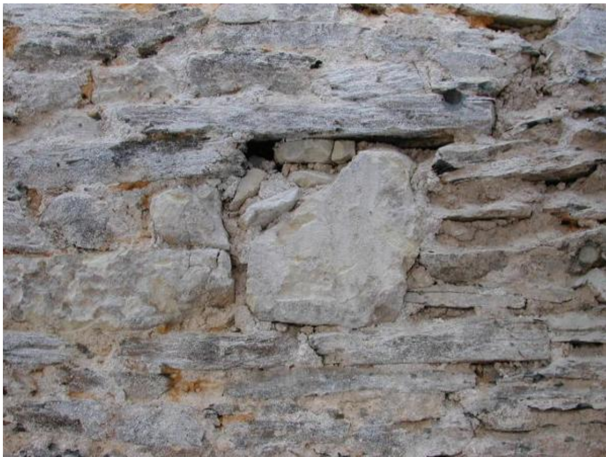
Corps de logis sud-ouest, élévation sur rue, 1er étage : trou de boulin extrême gauche.
